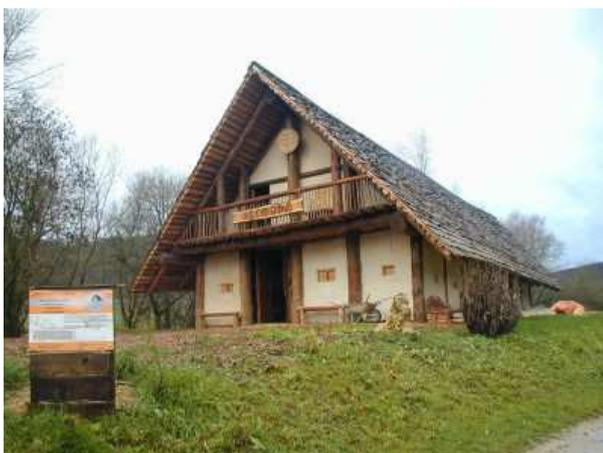
Das Langhaus wurde ausschließlich mit Vereinsmitteln rekonstruiert und hat Ausmaße von etwa 8 x 20 m. Bei dieser Raumdimensionierung kommt nach zimmermannstechnischer Einschätzung nur ein aufsteigend verlaufender First in Frage. Die Höhe des Dachfirstes schwankt zwischen 7 und 5 m.
