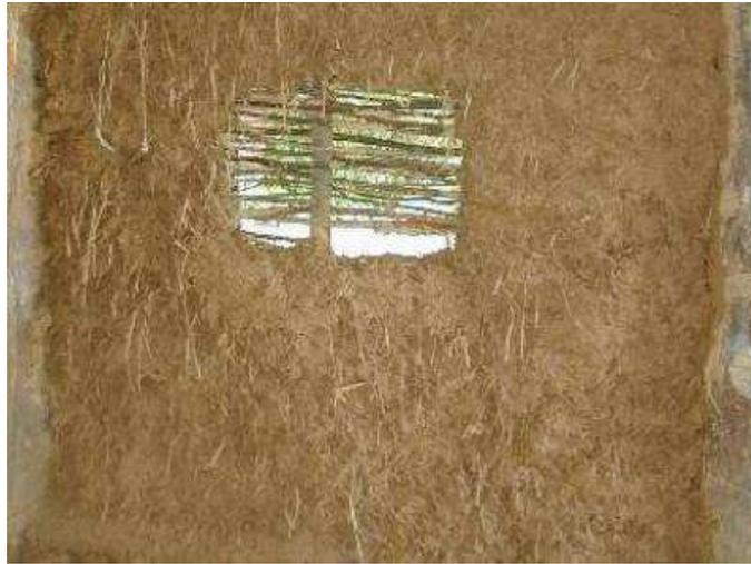
Materialien für die zweite Schicht: Lehm, Wasser, Hobelspäne (Abfallprodukt beim Schindel-Machen), per Hand wird alles kräftig durchgeknetet, die fertige Masse dann mehr oder weniger an die Wand geworfen.
