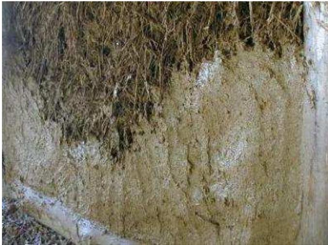
Die Wand ist innen und außen glatt verstrichen, Nach der Trocknungsphase müssen die Schwundrisse behandelt werden.
